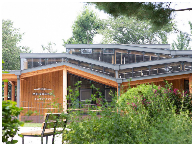
친환경 목조 건축물 조성(오동숲속도서관)
